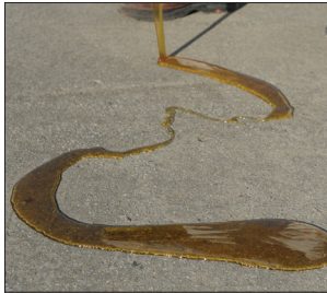
Pour Dampseal 101™ directly from bucket onto surface
